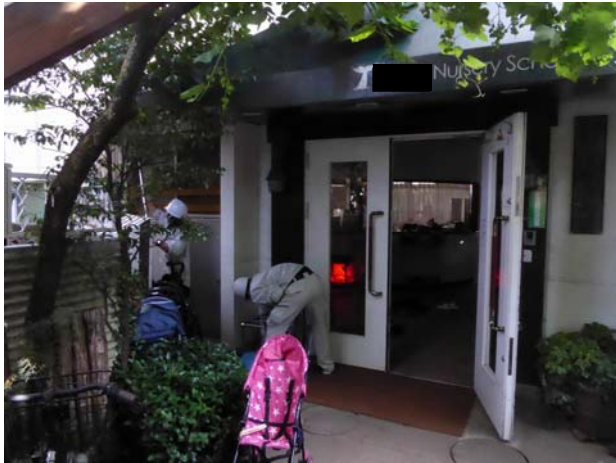
園舎正面玄関ーガラス戸・忌避剤塗布
