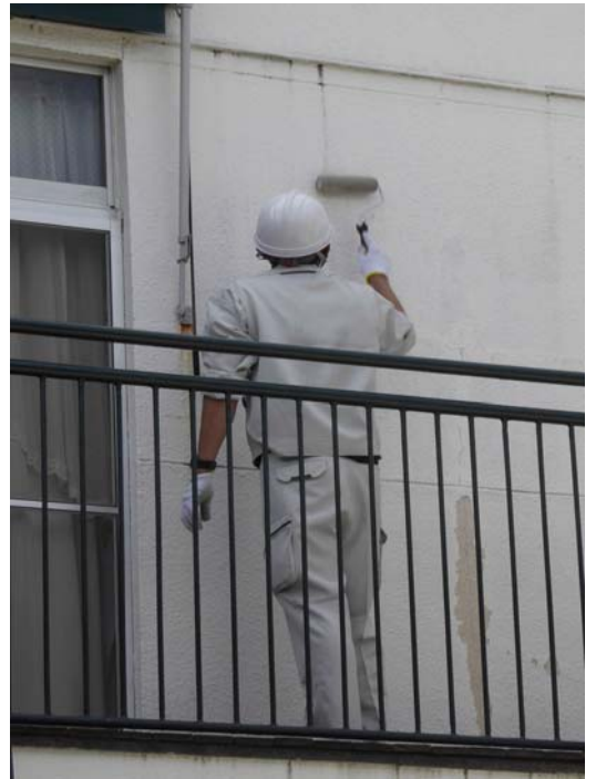
園舎2階壁面・忌避剤塗布
