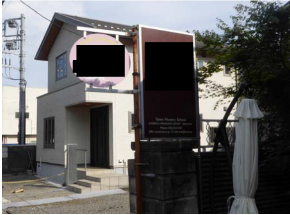
保育園正面全景
