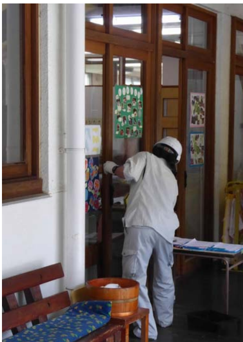
園舎1階壁・忌避剤塗布
