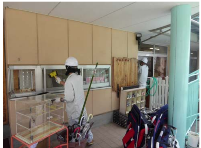
園舎-壁面・ガラス面忌避剤塗布
