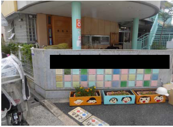
保育園正面全景
