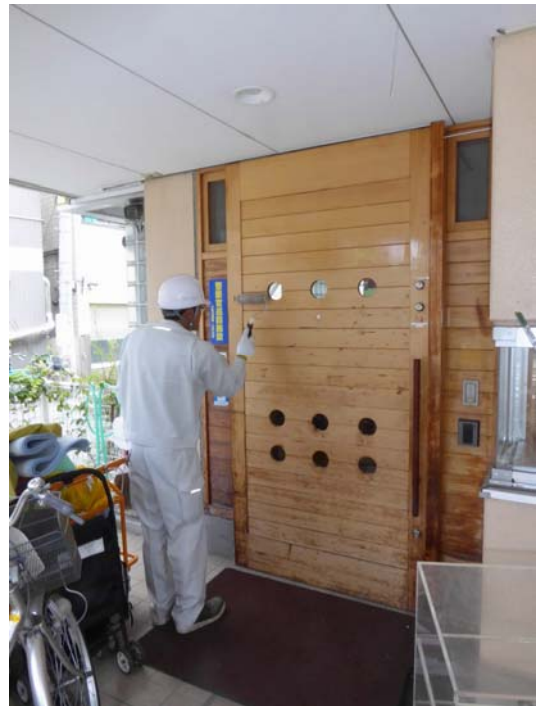
正面玄関・忌避剤塗布
